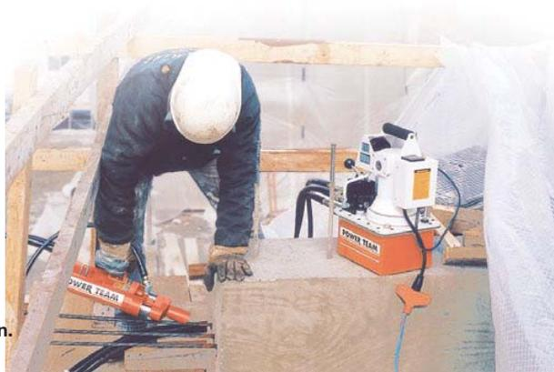
Modèle PE60 utilisé pour une mise en tension.
